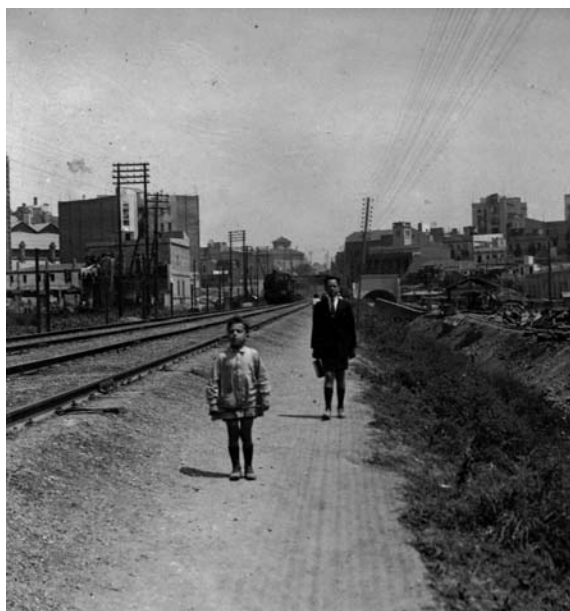
Voltants de les vies al carrer d' Antoni de Campmay durant les obres del metro transversal, 1925
