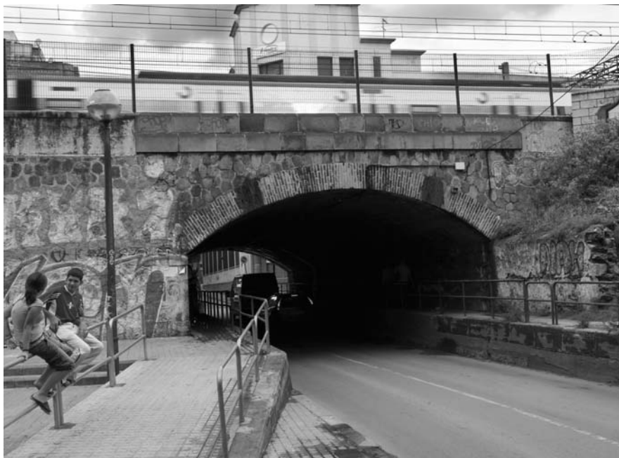
Pont actual del ferrocarril per sobre del pont de la Riera Blanca.
