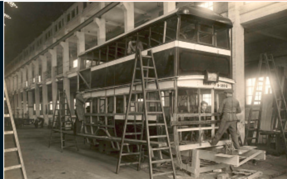
Construcció d'un vehicle de dos pisos a Lutxana.
