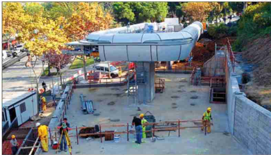
►► Estructura interna de la estación inferior, donde los viajeros subirán a las cabinas
